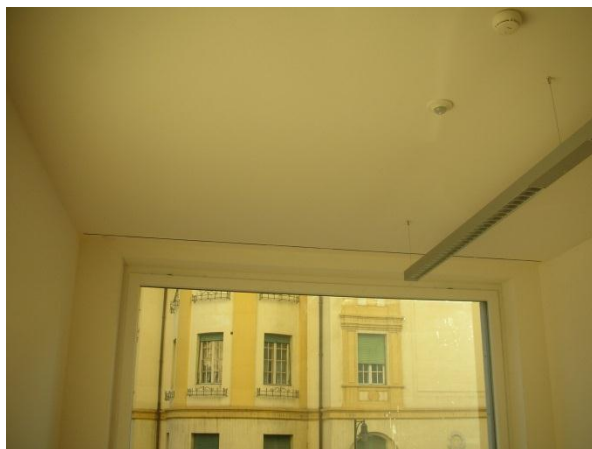
Riscaldamento e raffrescamento a soffitto negli uffici
