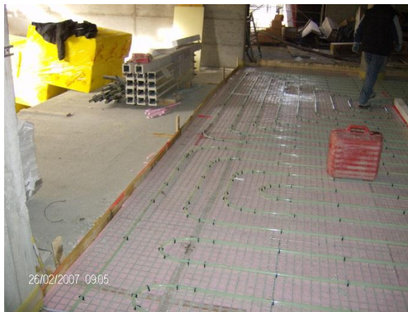
Riscaldamento a pavimento nei corridoi
